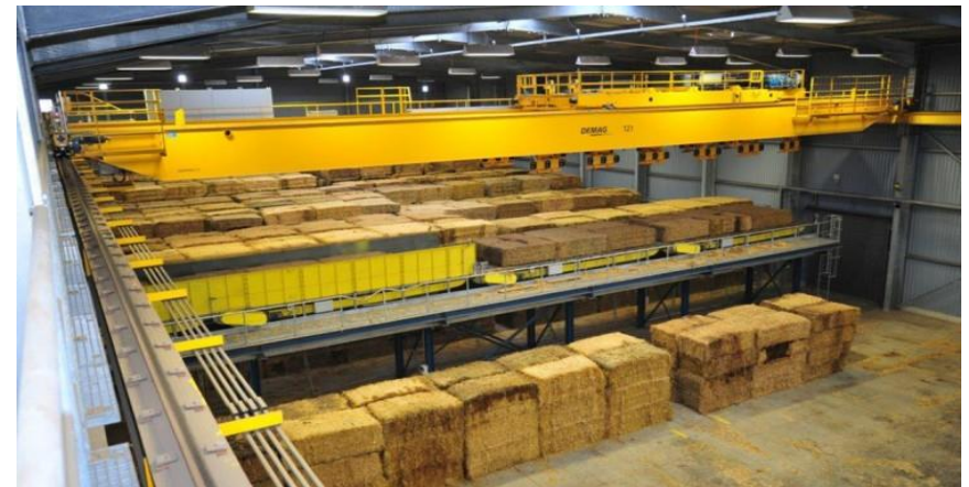
Bilder: Fjernvarme Grasten, Biomasse-HKW Emlichheim
