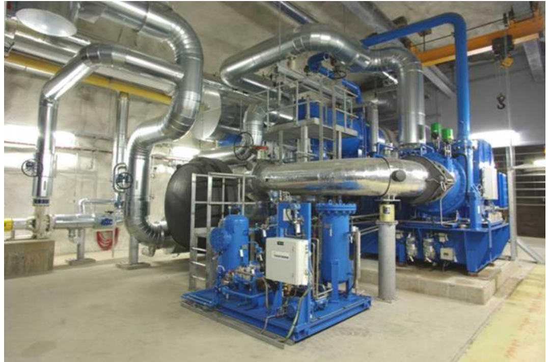
Meerwasser-Wärmepumpe Fernwärmeversorgung Helsinki Quelle: www.friotherm.de
