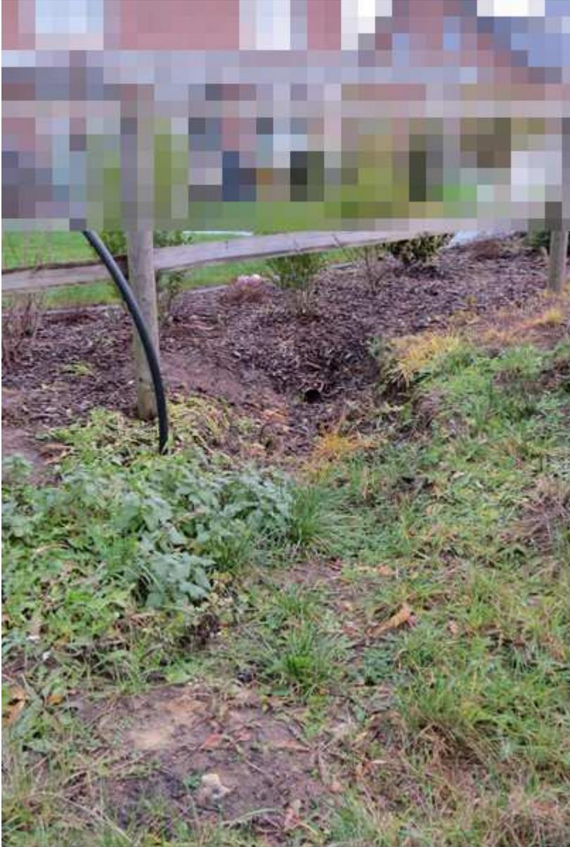
Abbildung 54: Unzulässige Entwässerung (zweifach vorgefunden)
