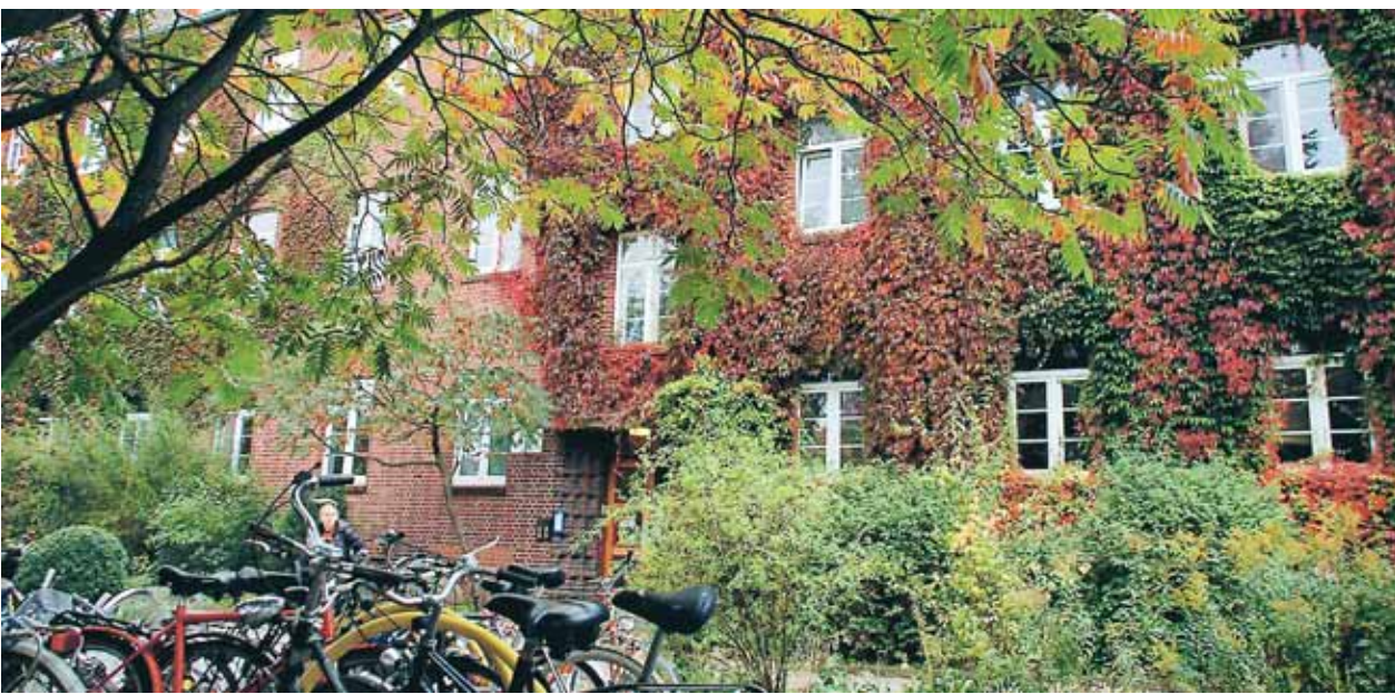
Der Beginn von Campus e.V.: Der Umbau dieses ehemaligen Kasernengebäudes zum Wohnheim.
