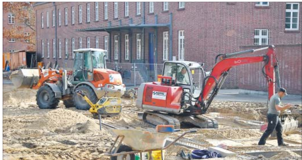
Auf dem ehemaligen Mensaparkplatz entsteht ein neues Gebäude. Foto: Sören Sieck-Pahl
